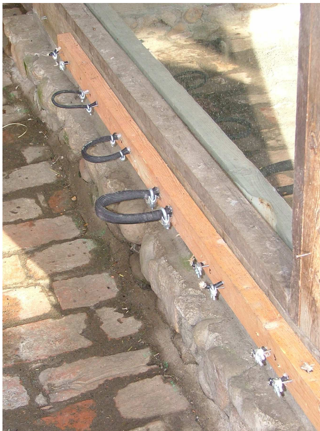
Obr. 4: Stodola pro kony vzadu, 03. březen (pořadí kabelů shora dolů: 5, 3, 6, 1, 2, 4)
