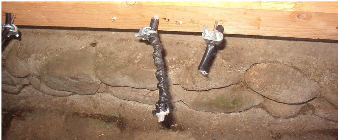
Obr. 2: Kabel č. 4 jeden den po zahájení, pohled zblízka
